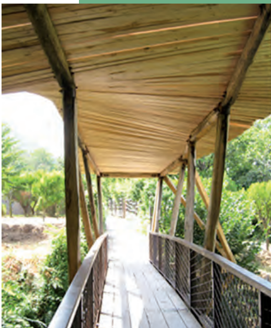
Passerella pedonale in legno a Monte Albino, Napoli
