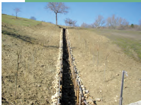
Fossa di raccolta e drenaggio a monte della strada provinciale realizzato con paratie "morte" (legno e pietra) ed ai lati i salici, che una volta cresciuti, svolgeranno il ruolo di siepe ripariale.
