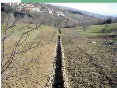
Fosso di raccolta e drenaggio a valle della strada provinciale realizzato con paratie "morte" in pietra locale e legno.
