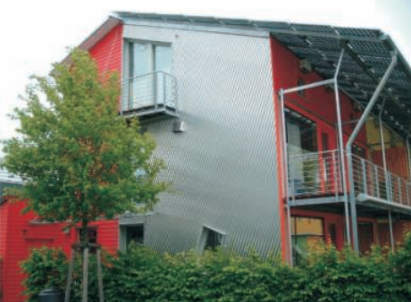
Quartiere Vauban, Freiburg (Germania), 2004. Progetto: Rolf Disch.
