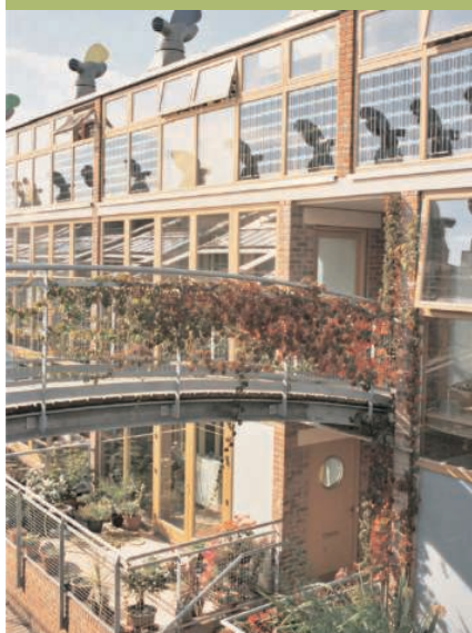
Complesso BedZED, Londra, 2002. Progetto: Bill Dunster con studio Arup. Nel quartiere di Beddington è stato realizzato l'intervento edilizio ad alta densità abitativa perseguendo l'obiettivo "Zero Energy Development", cioè con "zero" emissioni inquinanti e consumi di energia.
