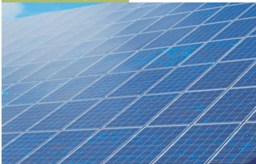
Sistema fotovoltaico del tipo vetro-vetro con celle in silicio policristallino.
