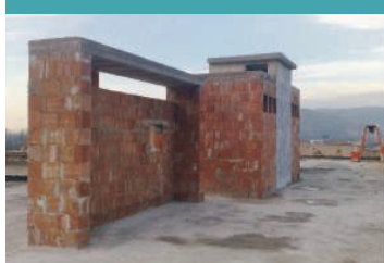
In copertura: solarium con pareti attrezzate e pannelli fotovoltaici (work in progress)
